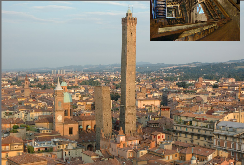
Bologna. Torre degli Asinelli e torre della Garisenda. Scale interne nella torre degli Asinelli.
